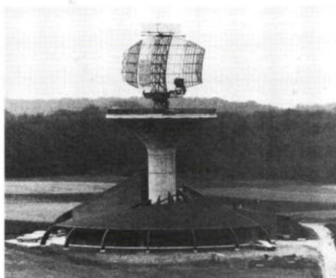
In Bertem, in de buurt van het vliegveld van Brussel, is onlangs de nieuwste radarinstallatie van België in gebruik genomen. De installatie, ter waarde van f 21 miljoen, is gebouwd en geleverd door AEG. Het systeem dient voor de bewaking van het luchtruim en heeft een bereik van 140 zeemijl, ofwel ca. 260 km. De gegevens van het systeem worden verwerkt in een centrale in Brussel en in de centrale van Eurocontrol in Maastricht.
